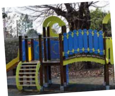
Rénovation en cours du Jardin d'enfants
