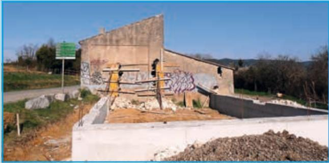
En début d'année 2014, des travaux d'agrandissement et de rénovation ont débuté (salle de réunion de 30 m<sup>2</sup> environ, construction de sanitaires, mise aux normes électriques, isolation des murs et de la toiture).
