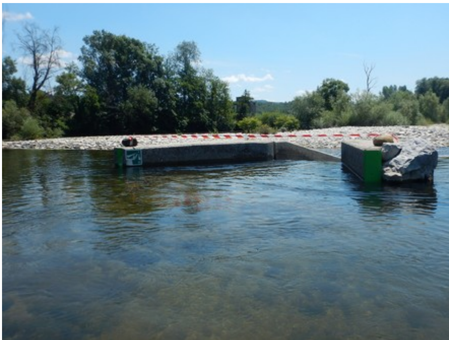
Dispositif de sécurité et signalétique temporaire mis en place sur la passe jeudi 25 juin.
